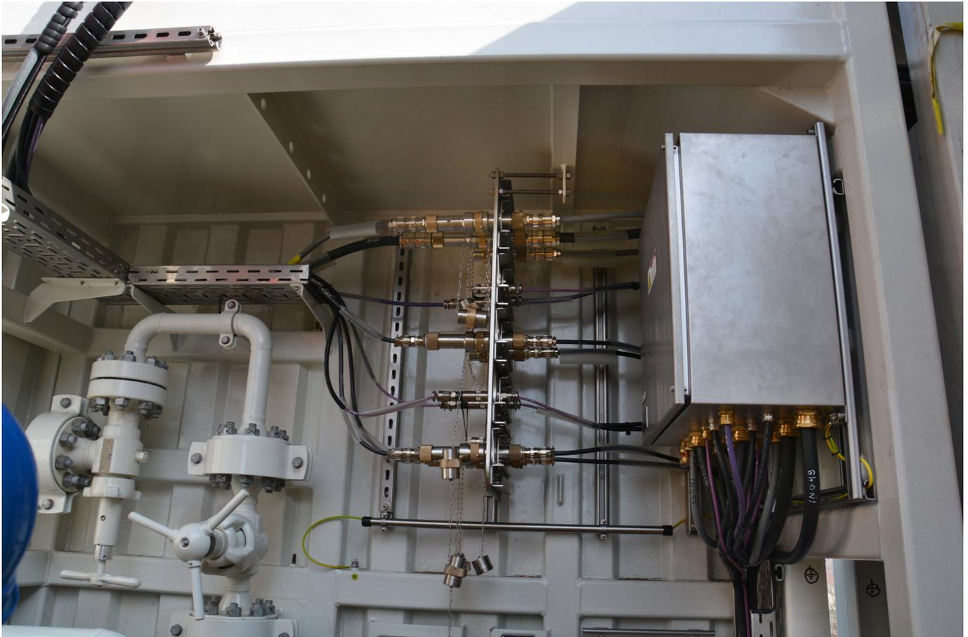
*Abb. 3: Geschaffen für explosionsgefährdete und raue Umgebungen HAWKE Steckverbinder (li) und HAWKE Kabelverschraubungen (re) im Einsatz.*
