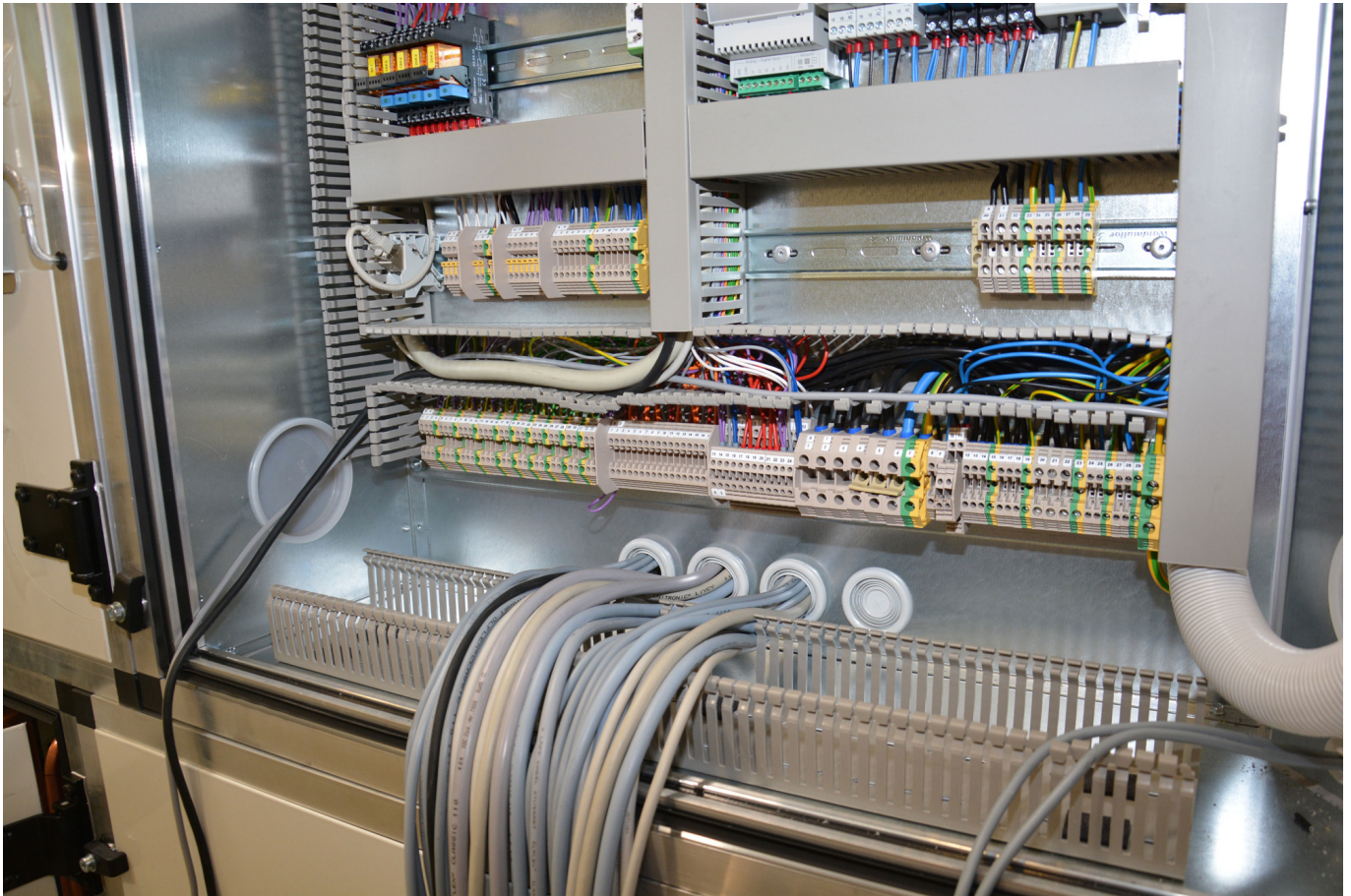
Abb. 6: Die Montage der Steuereinheit für ein Klimasystem
