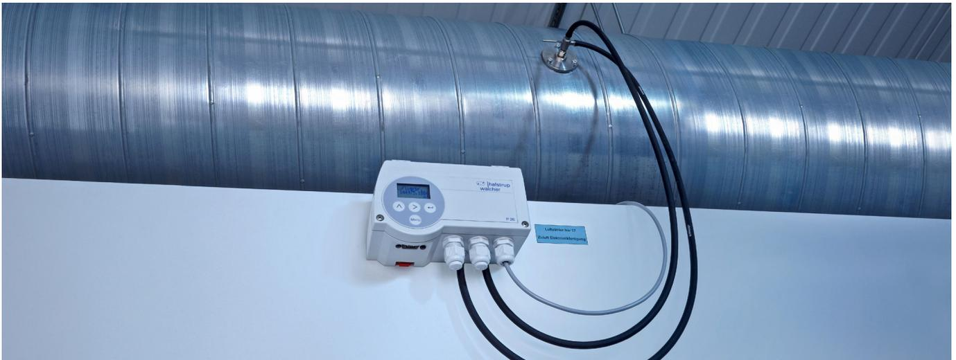
*Abb: 2: Differenzdruckmessgerät mit eingebauten Jacob Kabelverschraubungen und Blindstopfen im Einsatz.*
